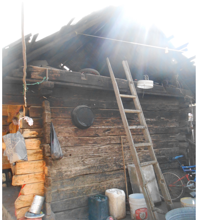
Imagen 6. Tapanco de un troje (Elaboración propia)
