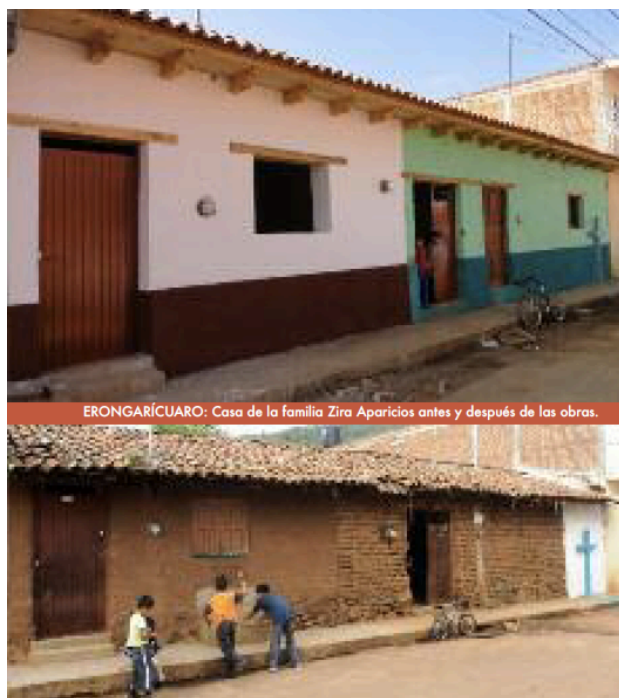
Imagen 10. Vivienda en Erongarícuaro, antes y después de las obras (Junta de Andalucía, 2015)
