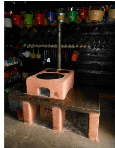
Imagen 3. Estufa mejorada de leña tipo Patsari en una de las viviendas analizadas (Elaboración propia)
